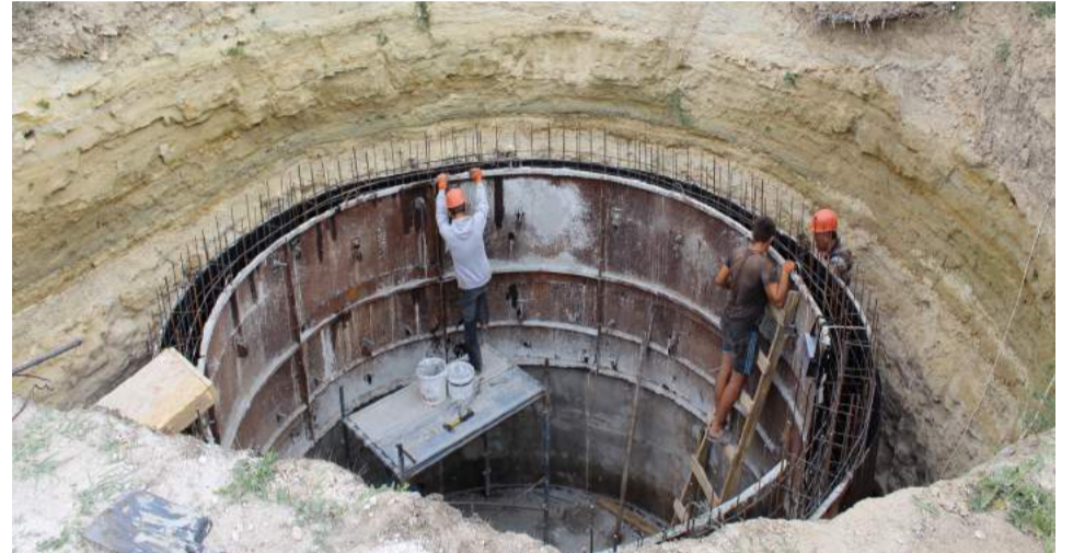
În imagine: Construcția stației de pompare a apelor reziduale în sectorul BTA - 16, în cadrul sectorului Albeni
