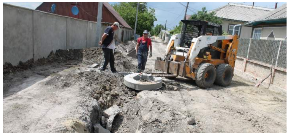
În imagine: Lucrările de construcție a canalizării pe str. Cetatea Albă
